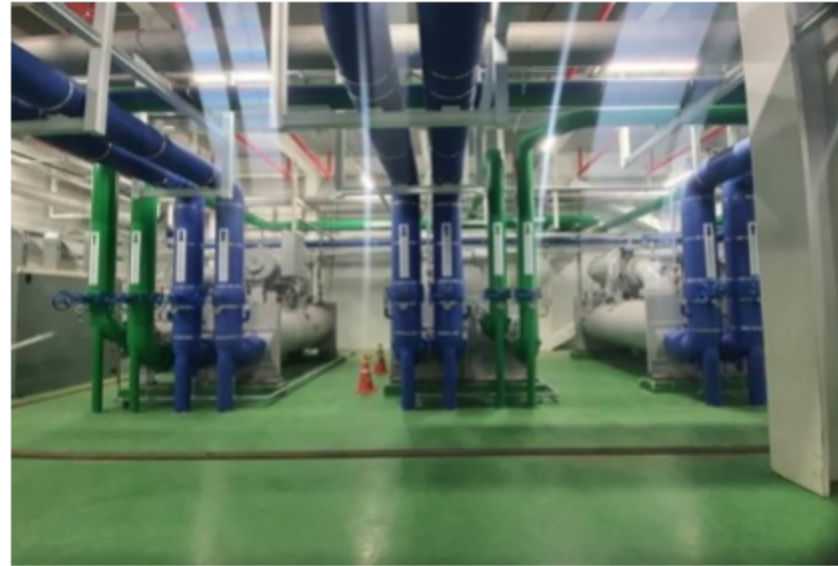
냉동기 배관 시공
