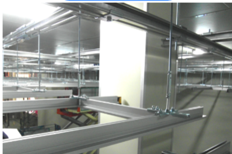
AL 몰드바 설치
