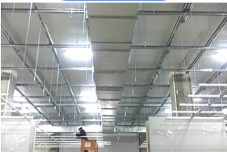
공조 덕트, 2차 전기 설치
