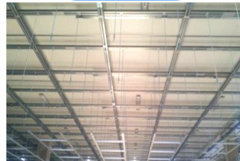
전산 볼트 및 점검등 설치
