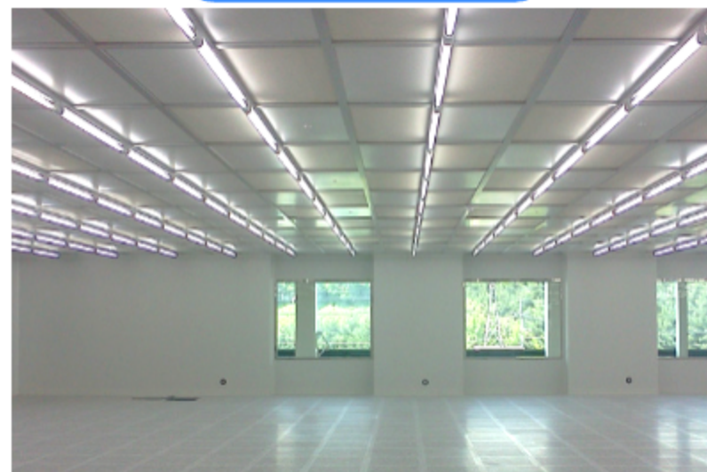
블라인드 패널 설치 및 마감
