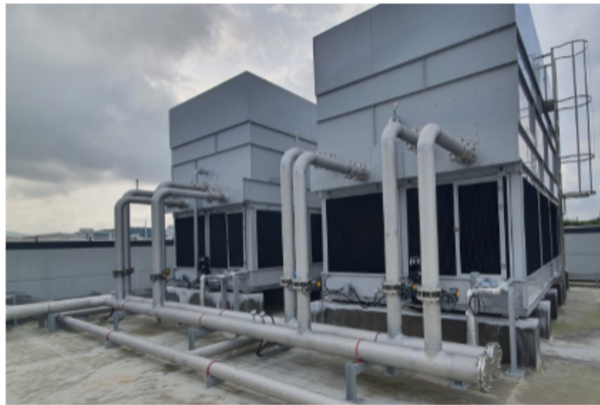
밀폐형 냉각탑 설치
