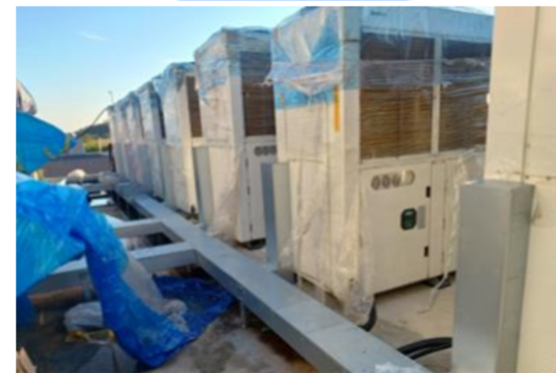
공조기용 실외기 설치
