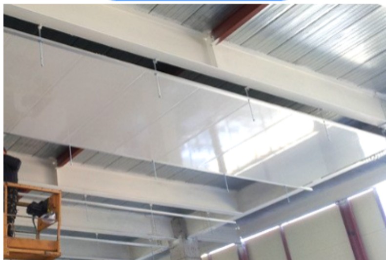
천정 T-bar &amp; 패널 설치
