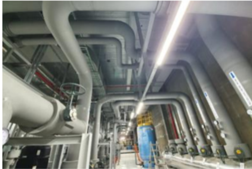
압축공기 배관 시공
