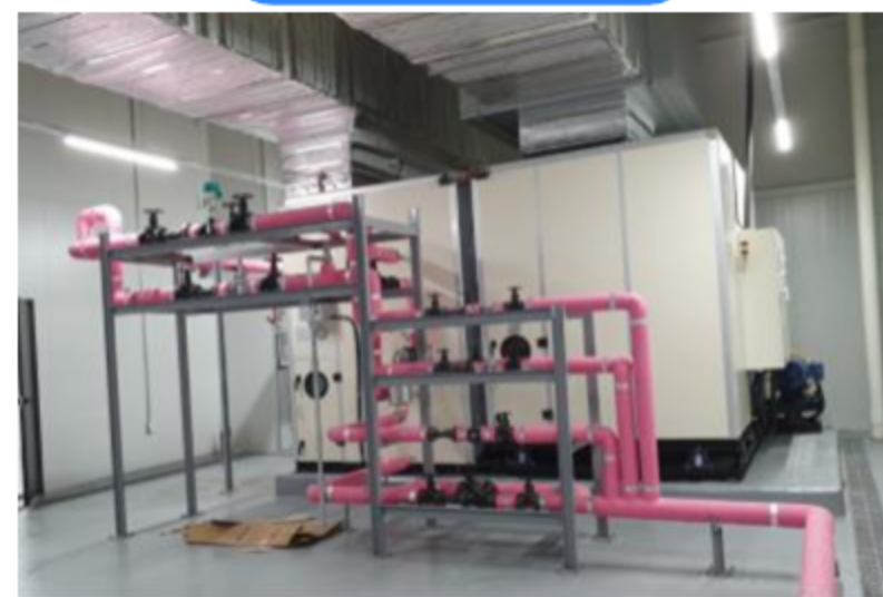
공조기 및 배관 설치
