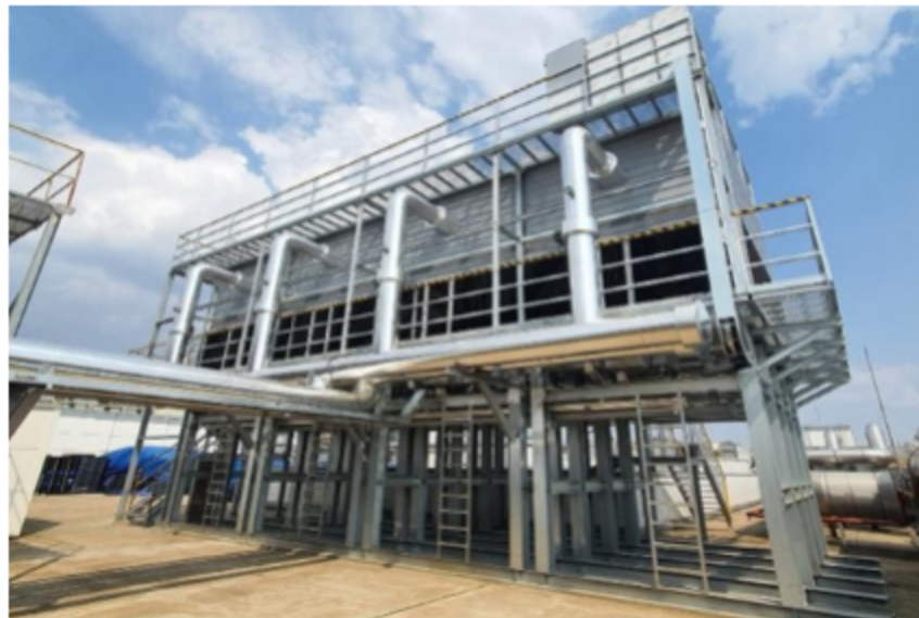
냉각탑 배관 시공
