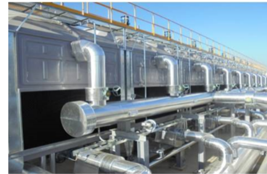
개방형 냉각탑 10,000CRT 설치
