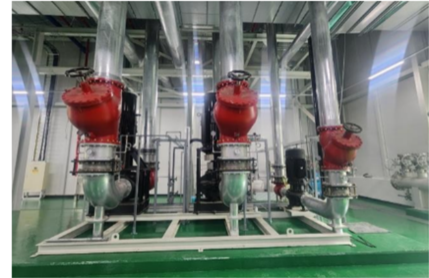
펌프 배관 시공
