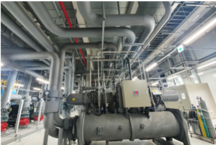
스크류 냉동기 시스템 설치
