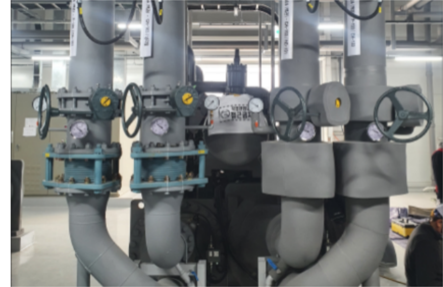
스크류 냉동기 시스템 설치
